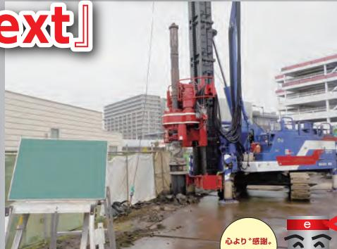
杭の種類  $\Phi 508.0 \text{ mm}$   $Dw750 \text{ mm}$   $L=56.5\text{m}$  10set 施工機械 DHJ-45
