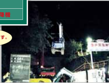
130tレッカーによるDHJ-08吊り上げ
