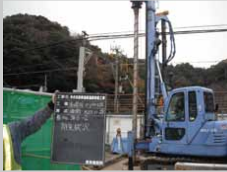
DHJ-08による先行掘削
