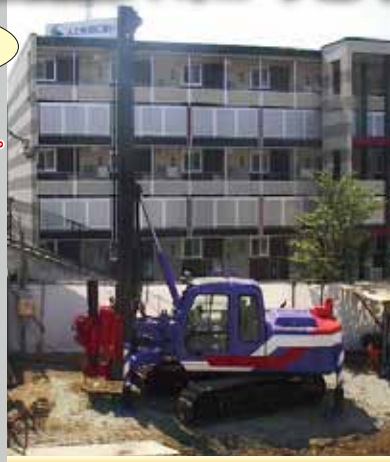
(仮称) 某新築工事
