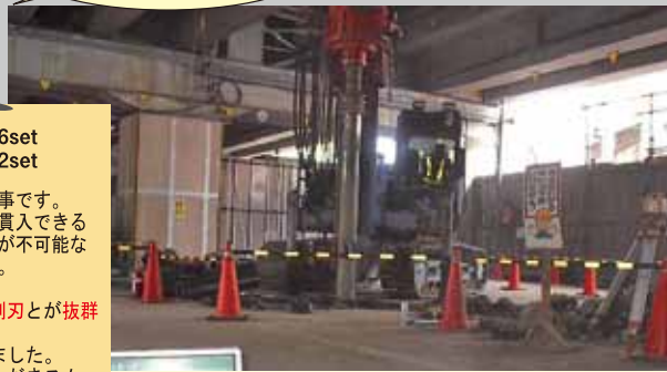
(仮称) 某高架下新築工事
