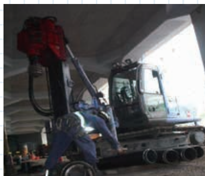
鉄道高架下施工例
