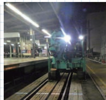
杭打機自走搬入例
